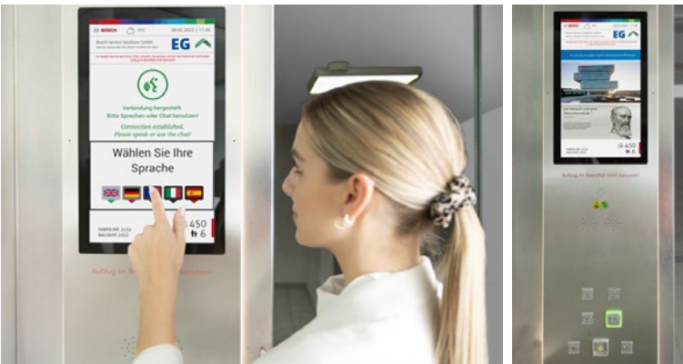
Mithilfe des Zwei-Sinne-Notrufs kann der Aufzugnotruf per Display getätigt oder können nützliche Informationen angezeigt werden.
