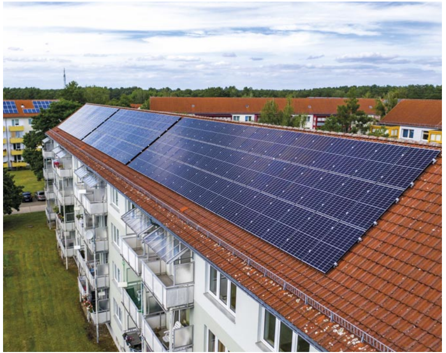
Die Mieterstromanlage von Solarimo wurde im Rahmen der Dachsanierung in Neupetershain errichtet.
