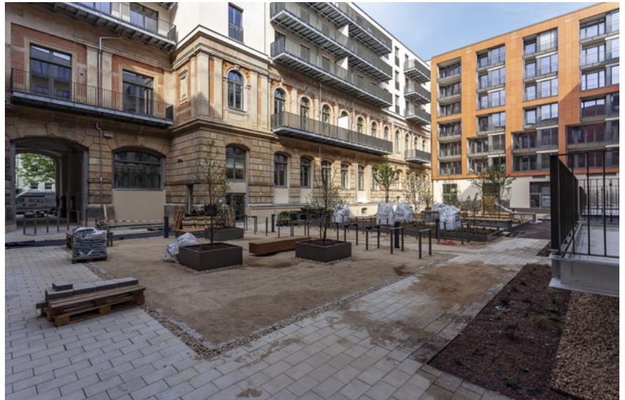
Bei der Sanierung des Altbaus achtete die CG Gruppe auf den Erhalt der historischen Bausubstanz wie zum Beispiel der bestehenden Klinkerfassade.
