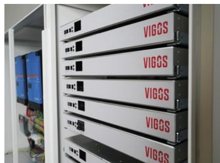
Blick ins Innere des Speichers
