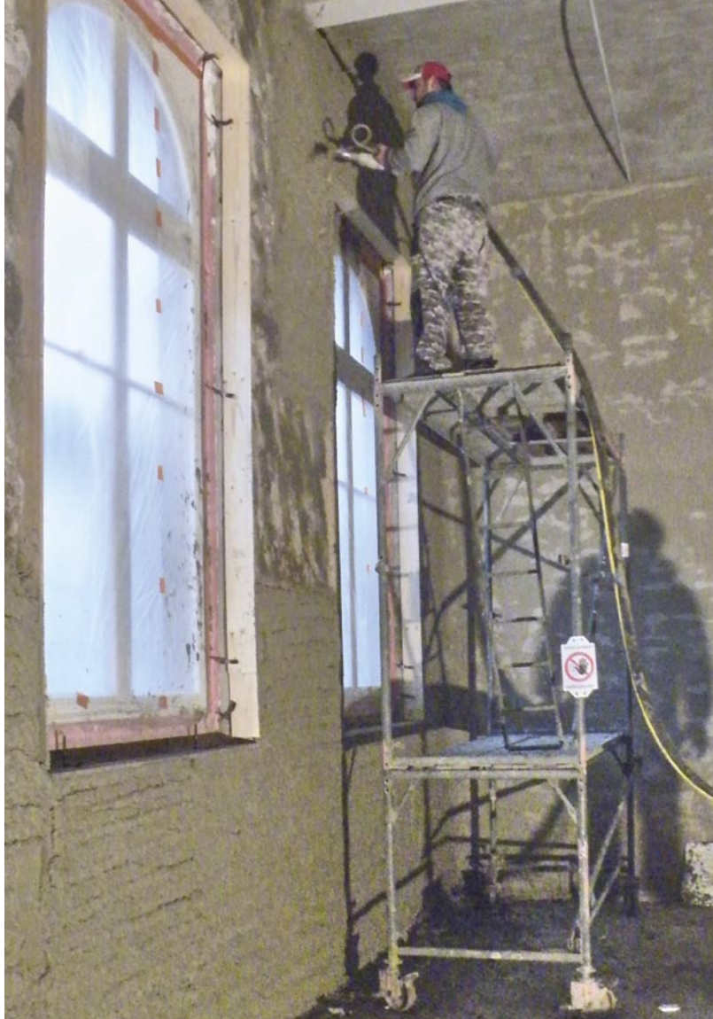
Tri-o-therm M der Schwenk Putztechnik wurde in Schichtstärken von 30 Millimeter aufgebracht.
