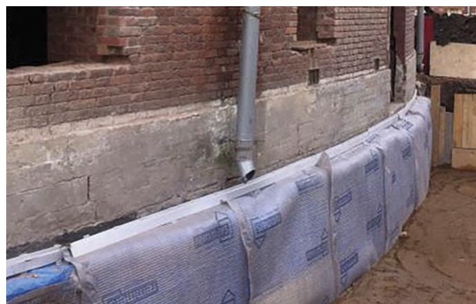
Die Gebäudesockel des Gefängnisses wurden fachgerecht abgedichtet.
