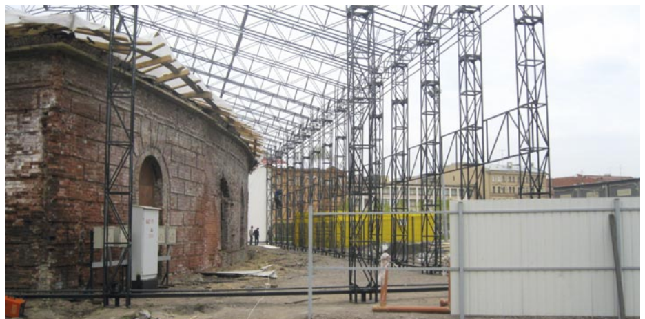
Ohne Dach und komplett verfallen: Die ehemalige Schmiede vor der Sanierung.
