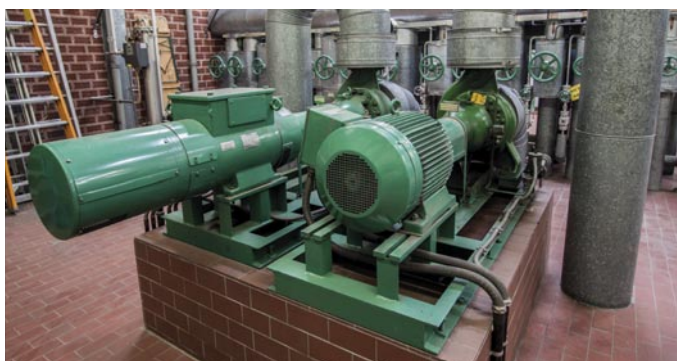
Deutlicher Unterschied: Die neuen Grundfos Pumpen (rechte Seite) verbrauchen nicht nur weniger Energie, sondern auch weniger Platz als die alten Pumpen (linke Seite)
