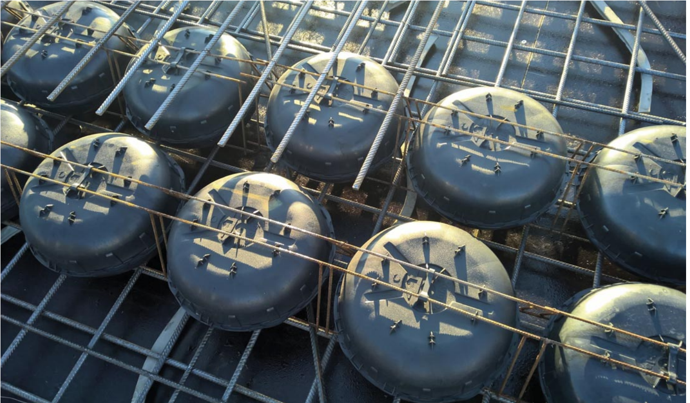
Das patentierte Cobiax-System besteht aus 250 Zentimeter langen Bewehrungsstahlelementen, in denen die Hohlkörper nach der Montage der Halbschalen fixiert werden.
