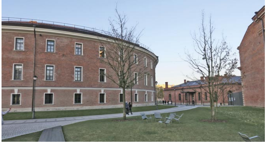
Der Prison Tower nach der umfangreichen Sanierung.
