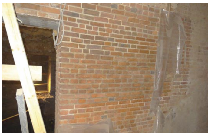
An den stark salzgeschädigten Mauerwerksflächen wurden Entsalzungskompressen eingesetzt.
